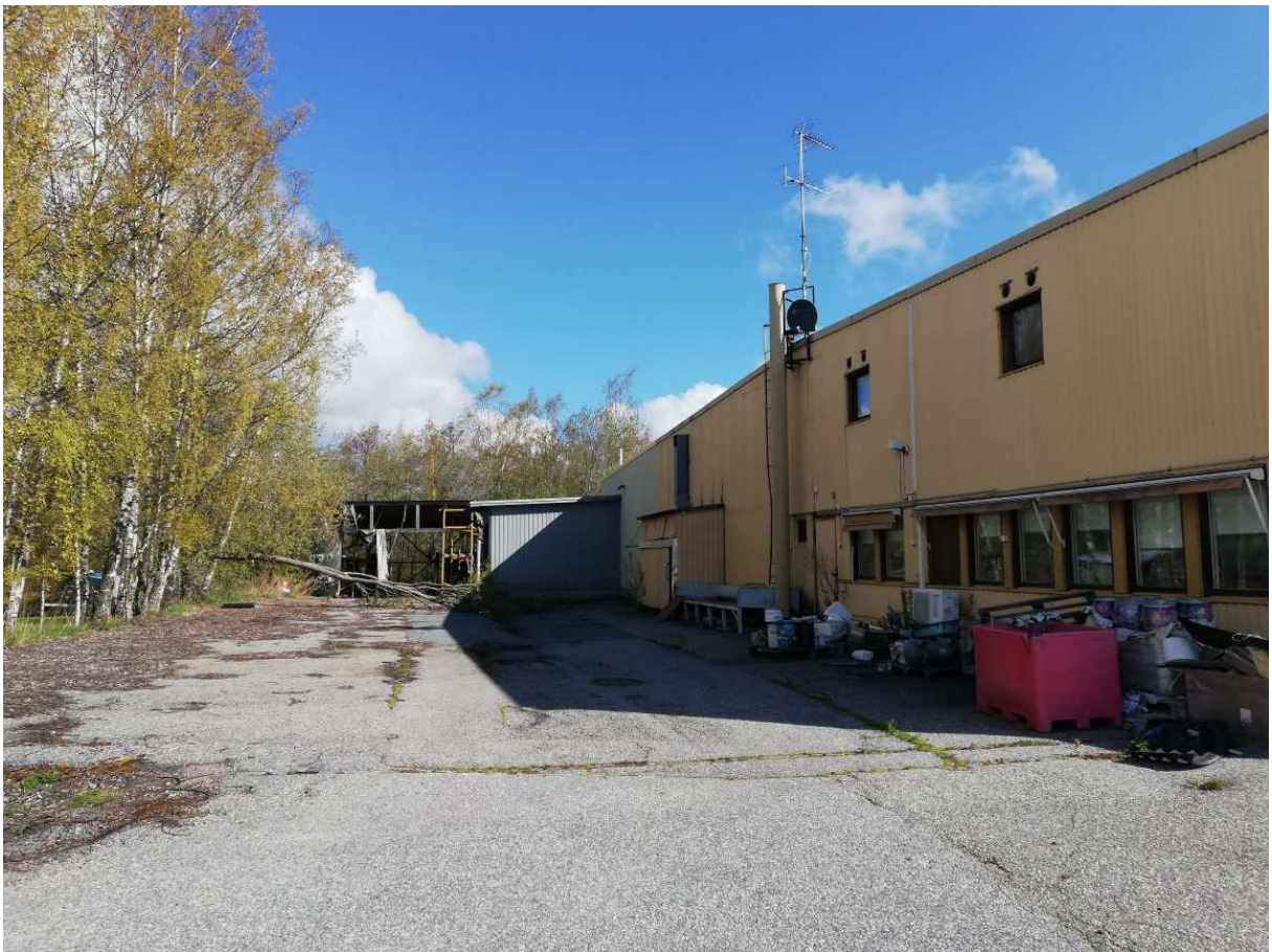
Kuva 3. Rakennuksen länsipäädyn piha-alue
